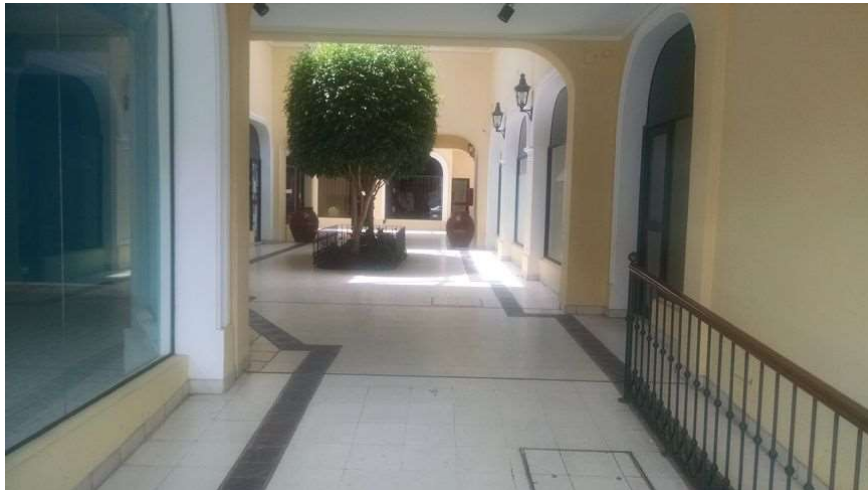
Fig. 23 Pasillo con cantero y leve forma irregular
