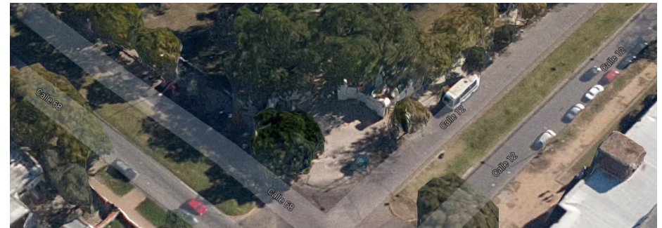
Portal de entrada, esquina de 12 y 68 (vista panorámica tomada de Google Maps)
