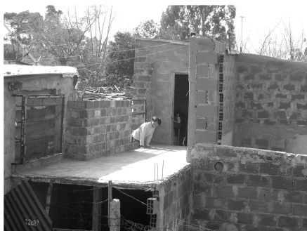
Figura 52. Cava Chica / construcción espontánea Elaboración propia [fotografía del autor]
