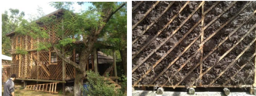
Figuras 5 y 6: Técnica de quincha en ejecución.
