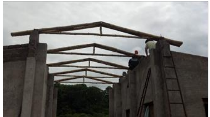
Figura 9. Montaje de reticulado
