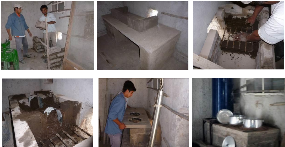
Figura 19. Capacitación en construcción de cocina a leña mejorada
