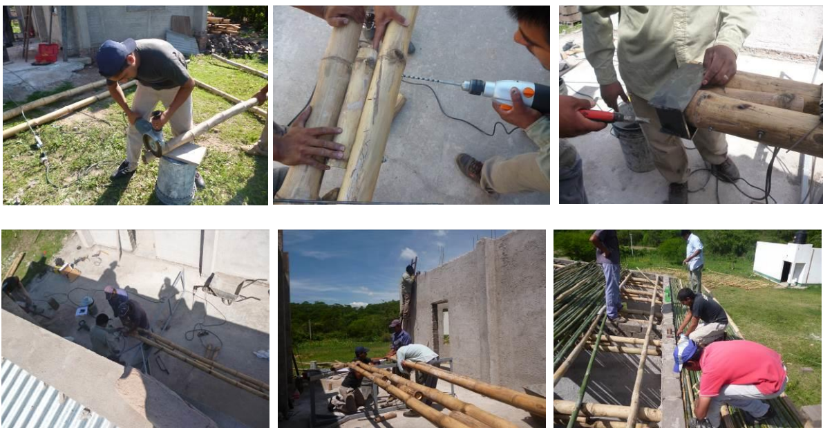
Figura 17. Capacitación en bambú – Viga de sección compuesta
