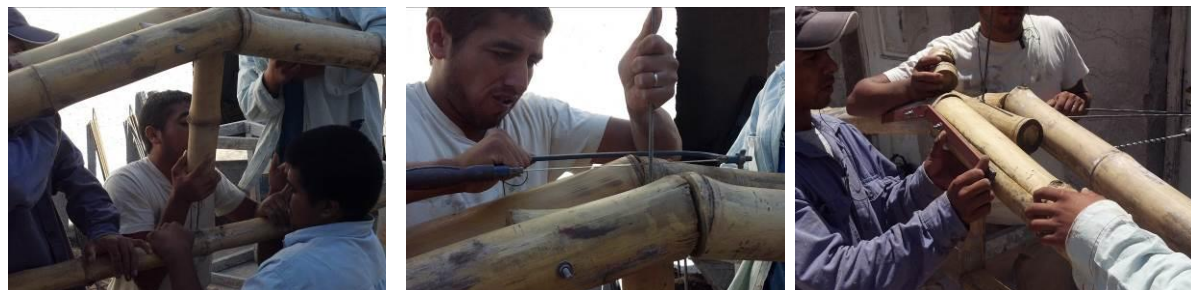
Figura 18. Capacitación en bambú - Cabreada
