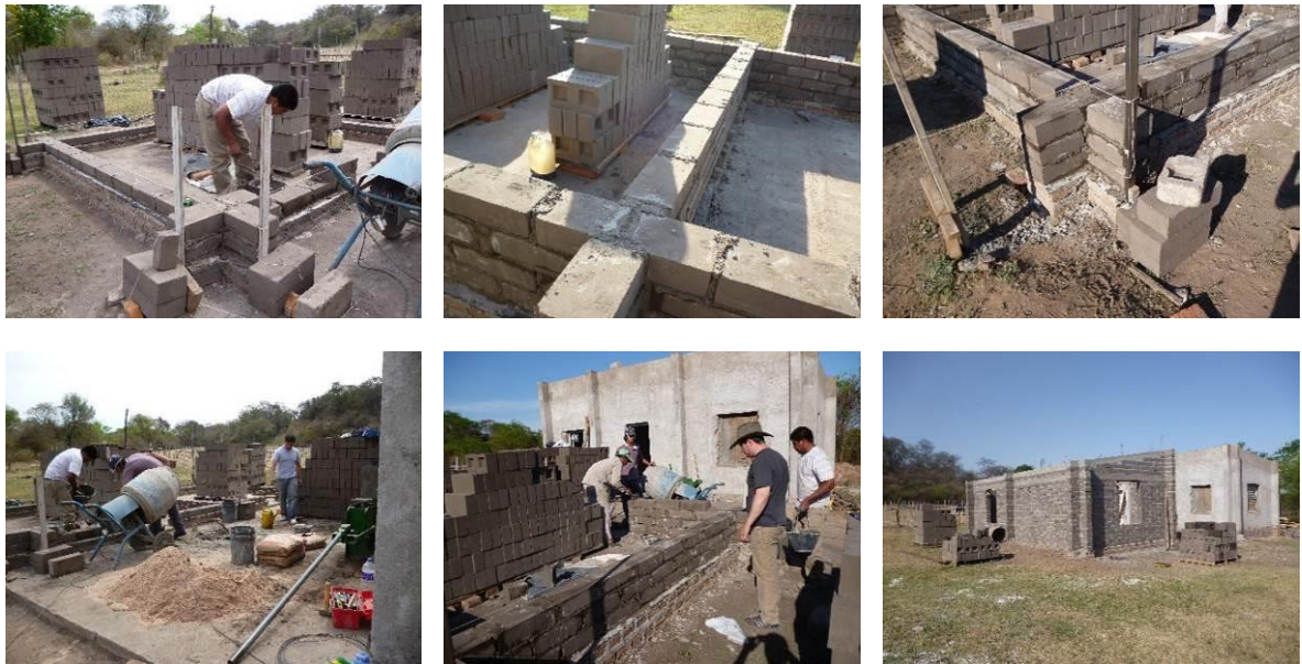
Figura 5. Proceso de fabricación de mampostería de BSC
