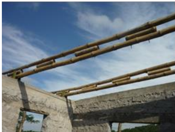
Figura 7. Montaje de viga de sección compuesta
