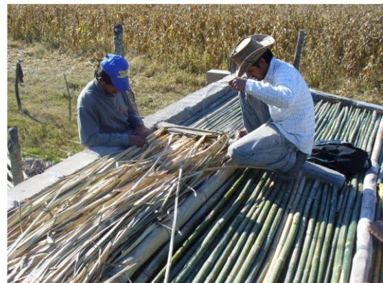
Figura 11. Colocación de totora en cubierta
