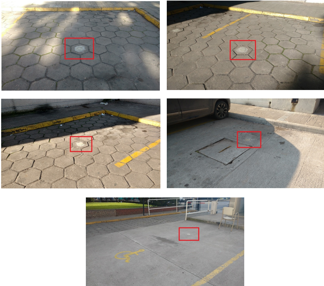
Figura 32 – De izquierda a derecha y de arriba hacia abajo, imágenes de los sensores de ocupación S-001, S-002, S-003, S-004 y S-005
