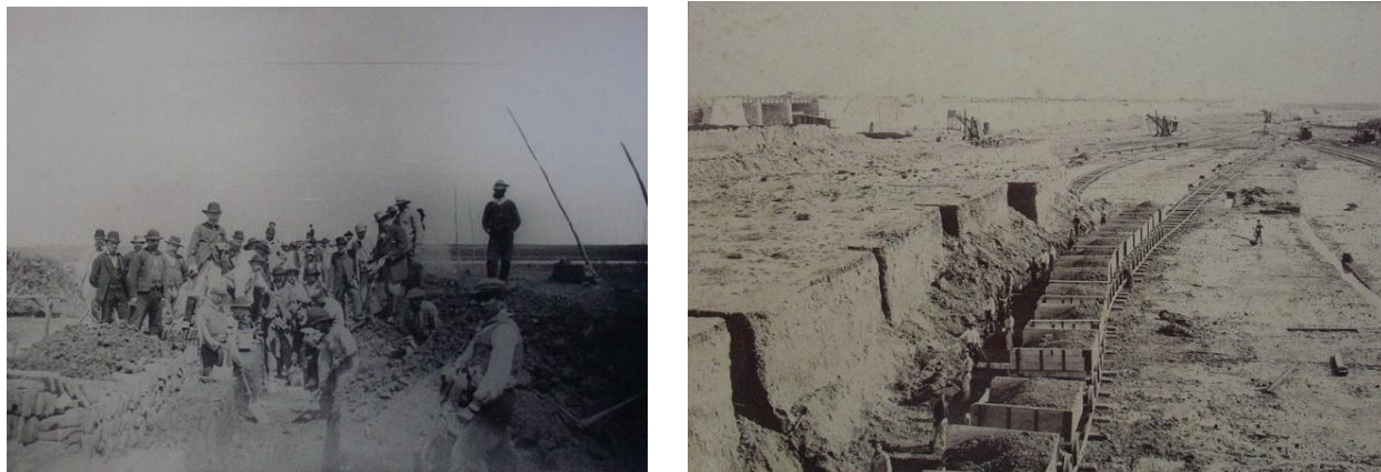
Trabajadores y obras de construcción de La Plata. 86
