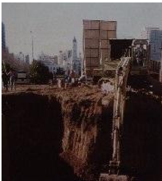
Obras para la construcción de la cisterna (GARCIA, septiembre de 1999: 85).
