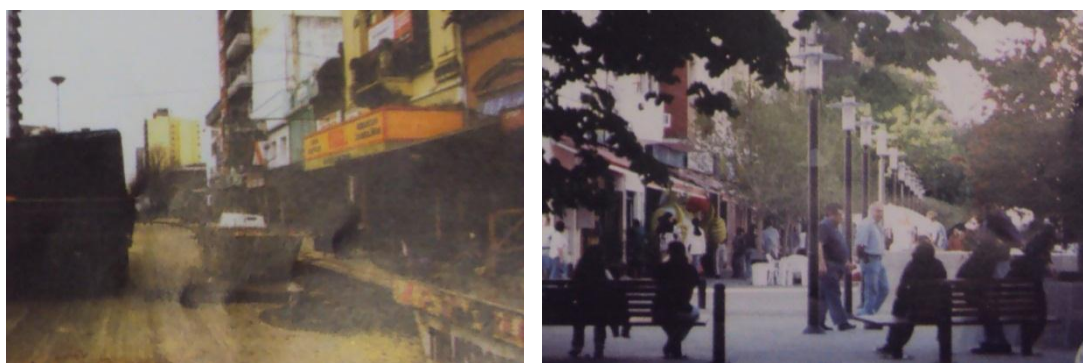
Antes y después de la obra (CEPA. Revista Ambiente , noviembre de 1999:65)
