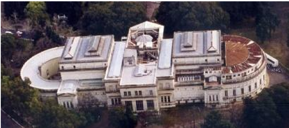
Figura 9. Construcción de laboratorios en la parte superior del ala Este del edificio, década 1960.
