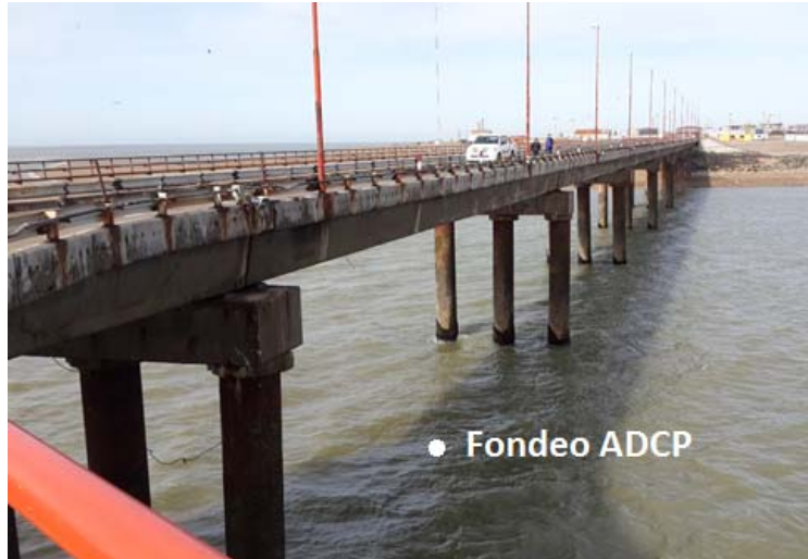
Figura 3.4: Sector de fondeo ADCP – Muelle Punta Loyola. Fuente: Relevamiento Fotográfico.
