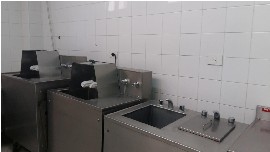
Imagen 4 - Área Sucia – Estado Inicial
