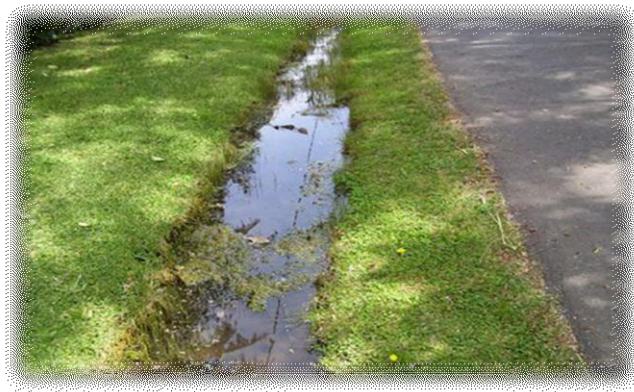
Figura 1.3. Sitio 1.3. Típica zanja de drenaje domiciliario en La Plata, el agua se ve translúcida.
