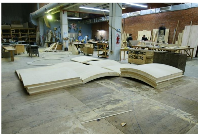
Figura 5.27. Construcción de los paneles de madera en los talleres del TA.
