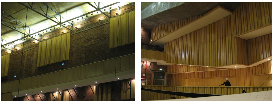
Figura 2.15. Fotografías de la Sala Principal de la Usina del Arte de la Ciudad Autónoma de Buenos Aires en las que se pueden ver dos clases de difusores acústicos.
