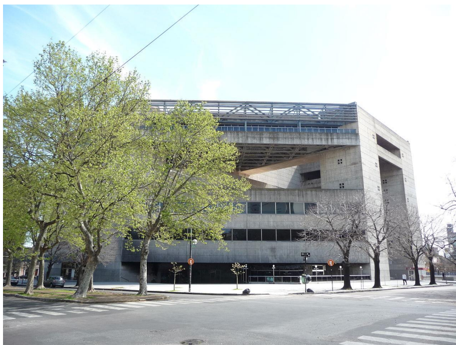
Figura 4.1. Exterior del edificio del TA, esquina de 9 y 53. 18
