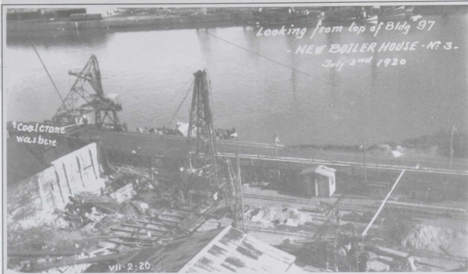
1920- Swift, construcción de las nuevas calderas
