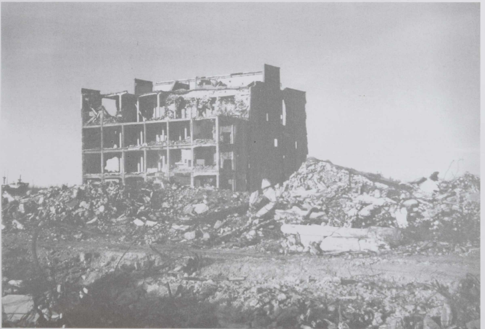
1985- La demolición del Frigorífico Armour. La caída de un gigante.
