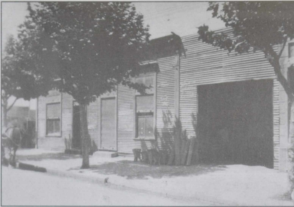
1939- Montevideo 1031. Depósito de Forrajes de los Hnos. Rimoldi.
