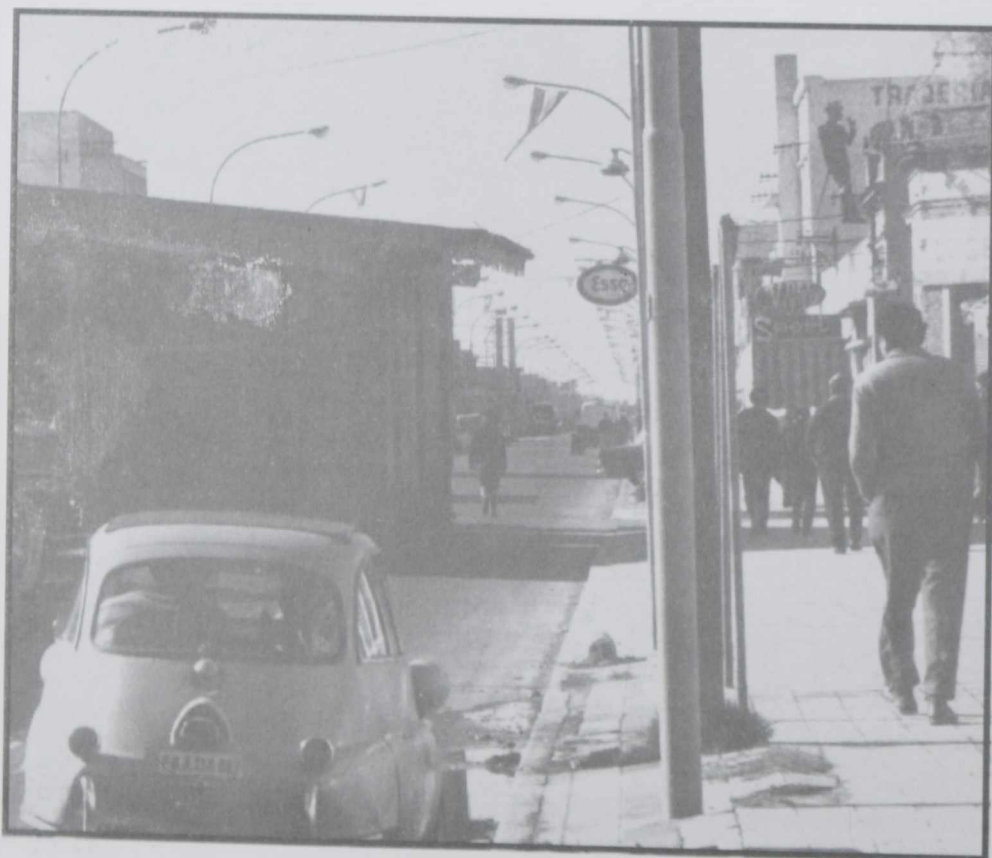
1970- Montevideo al 1400. Ultimos movimientos de casas, ahora con camiones.(Foto LAG)
