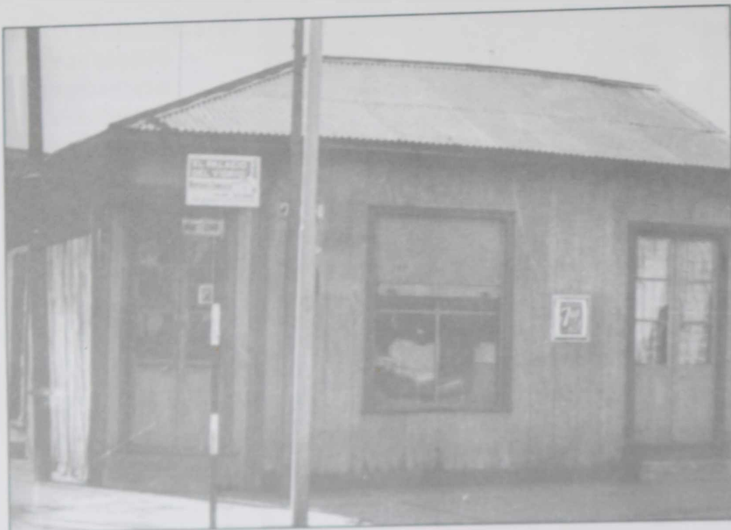
Escuela 35 (2). Montevideo 1002 esq. Punta Arenas (12 Elisa Mejido). Propiedad de Juan Berisso donde funcionó por primera vez la escuela entre 1885 y 1900. (foto Eri Brovedanni 1970).
