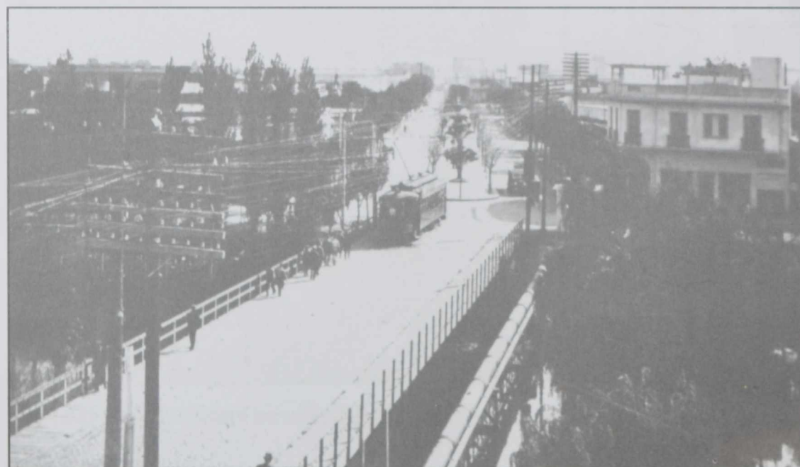
1935- Al puente se lo denominó 3 de Abril en 1957 en homenaje a la autonomía. Al fondo la rambla de la calle Montevideo.
