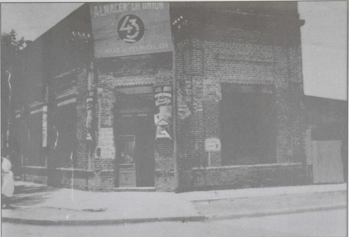
1938- Montevideo 1215. Almacén de Cruz y Rimoldi; la construcción es de 1926 aproximadamente.
