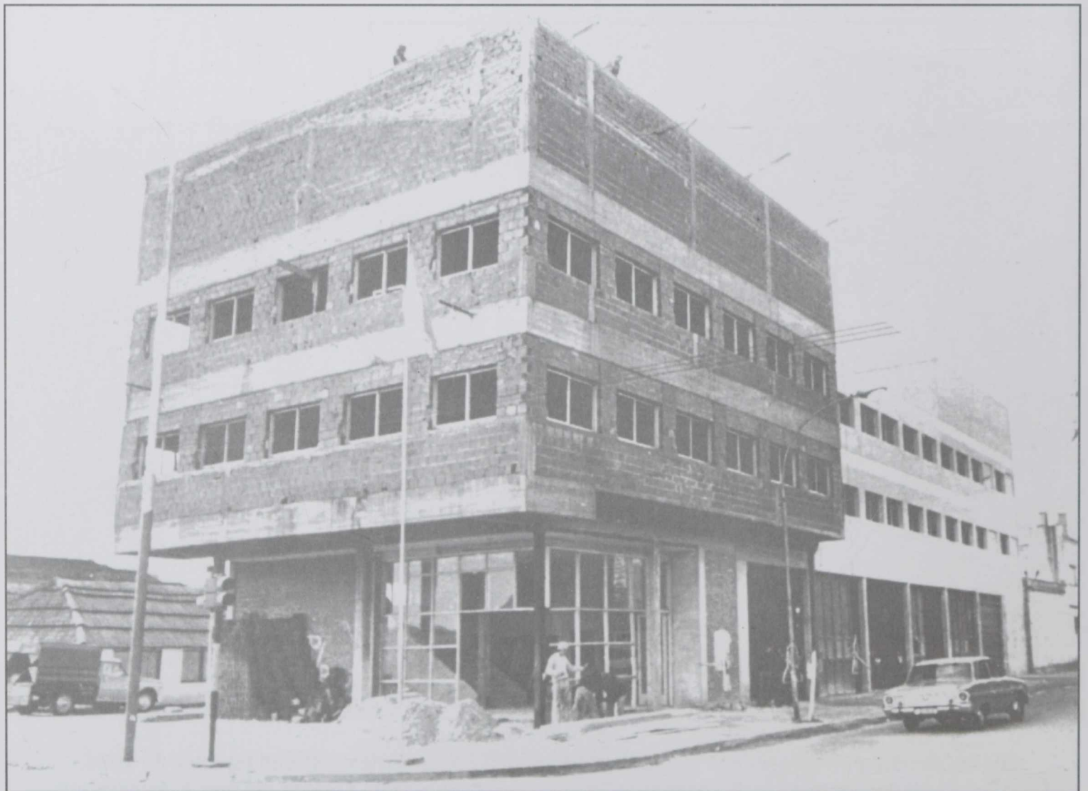
1978- Construcción de la actual sede de la Sociedad de Bomberos Voluntarios, Génova (7) esq. Trieste (164)
