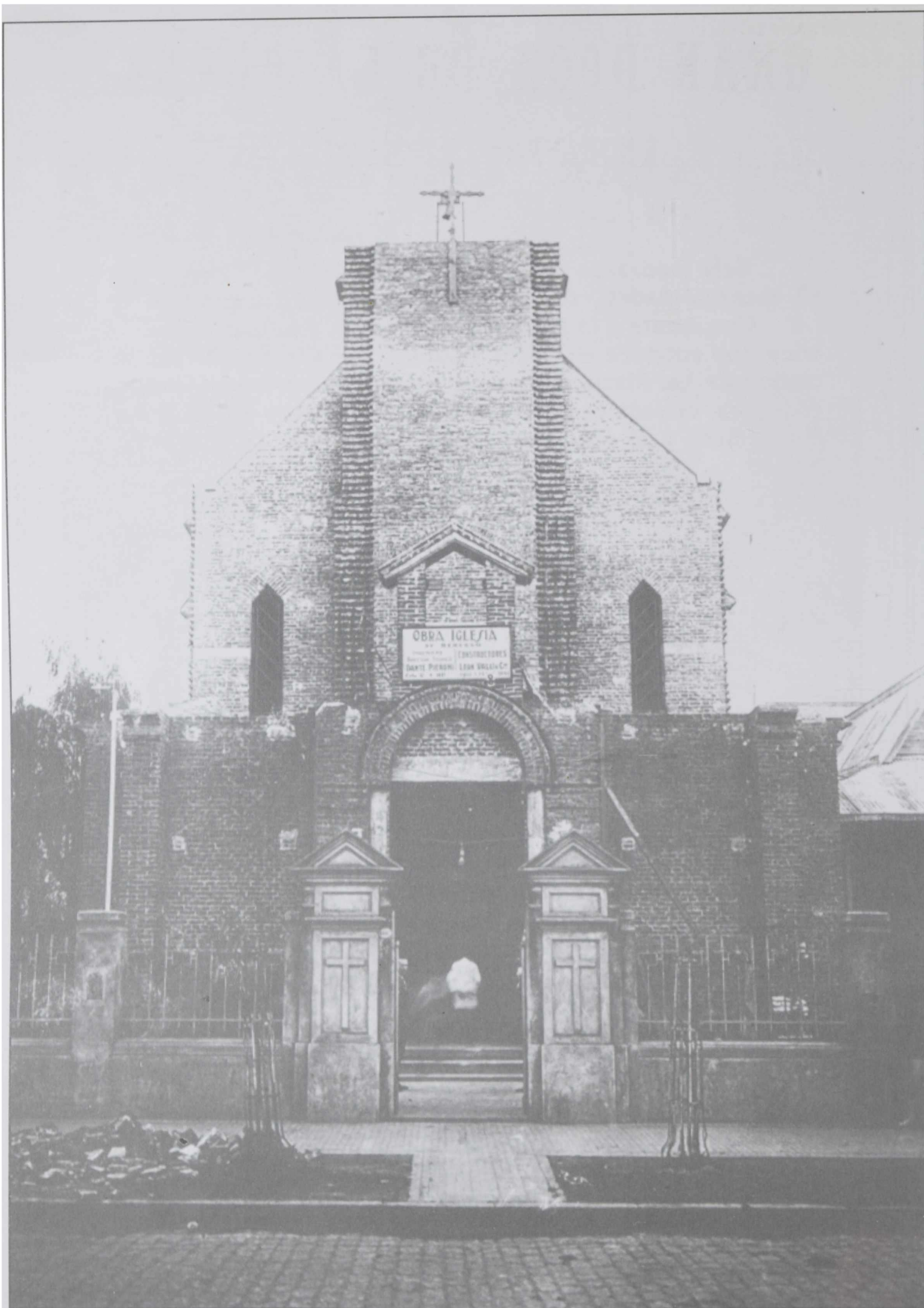
1931- La Iglesia María Auxiliadora que había sido inaugurada en 1927, aun en construcción.
