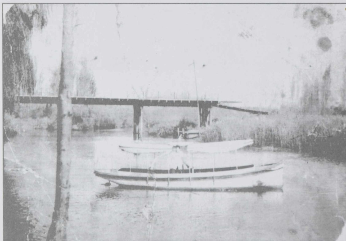
1932- Palo Blanco. Primer puente sobre Río Santiago construido en 1915
