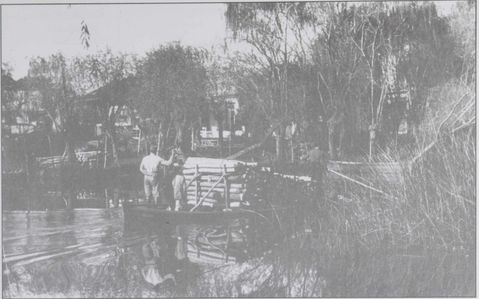
1964- Canal de desagüe Génova al 4600. Transporte de palos de sauce.
