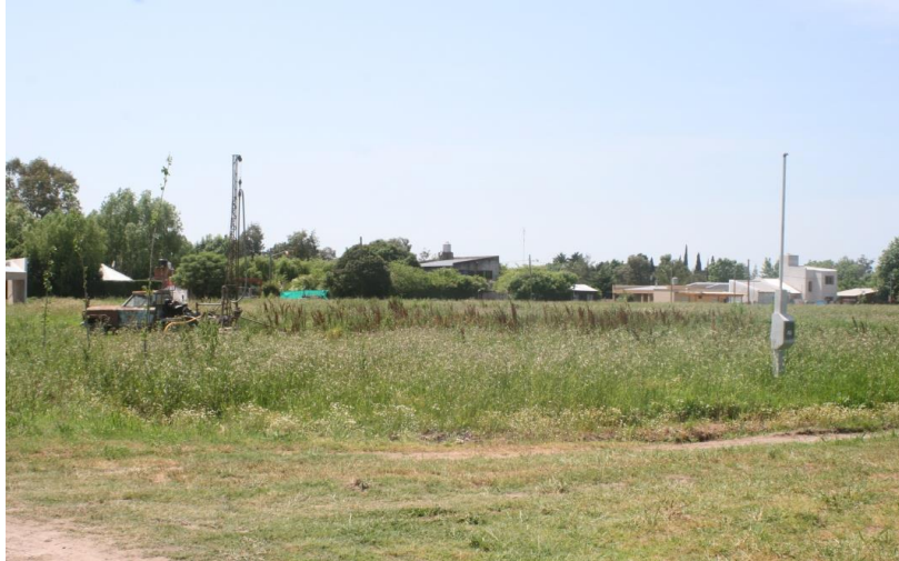
En la imagen se puede apreciar la máquina perforadora y el poste de luz para la futura construcción Una planificación urbana que poco o nada tiene de sustentable. Imagen Propia
