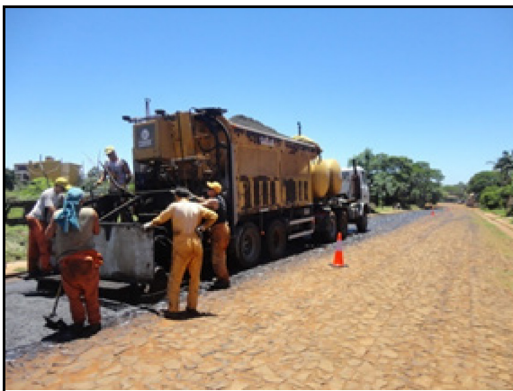
Figura 5.5 - Elaboración y colocación de la mezcla con planta ambuloperante
