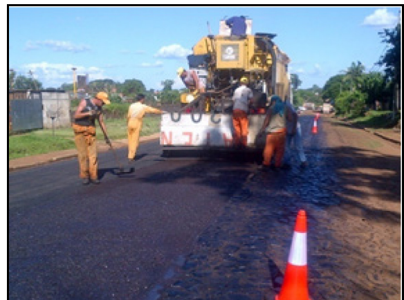
Figura 5.6 - Aspecto que presenta la mezcla recién colocada
