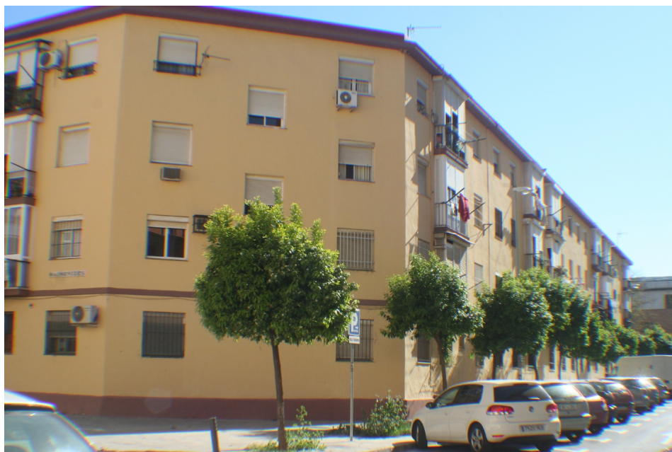
Fig. 11.3 Esquina N del edificio RENFE
