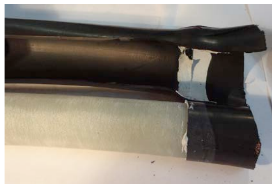
Fig. 15. Tubo de control de campo ya retirado
