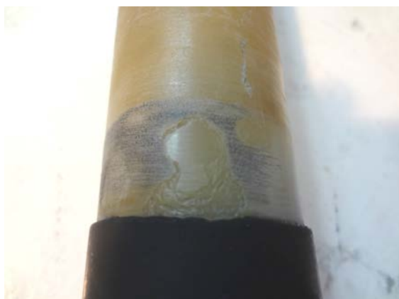
Fig. 16. Extremo de la capa semiconductor defectuosa y degradación del aislamiento
