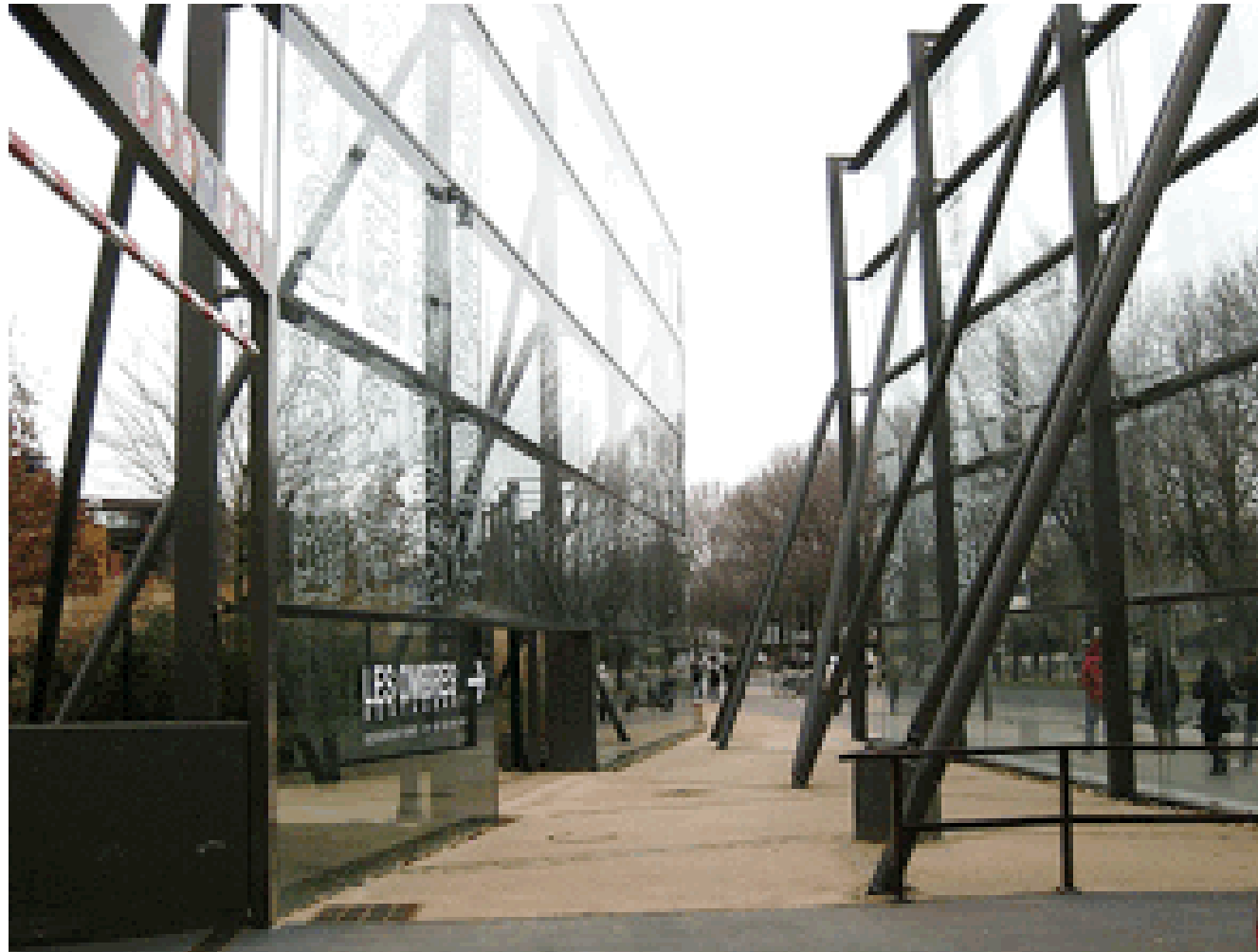
(Fig.15) Vista de los planos vidriados de la fachada norte.
