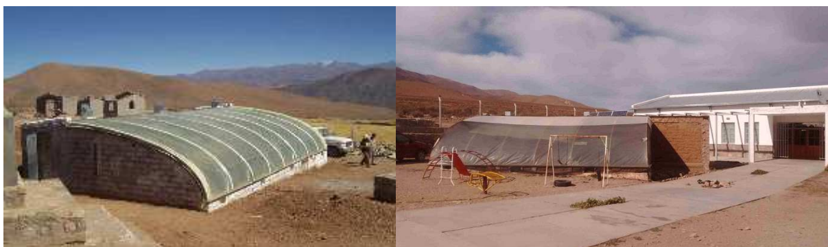
Figura 2a: Rosita1 dimensiones y diseño original (año 2004) Figura 2b: Foto 2016, invernadero original modificado
