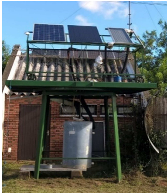
Figura 3: Imagem da montagem da bancada experimental.
