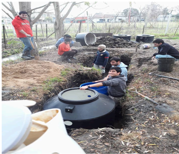
Figura 16. colocación sépticas
