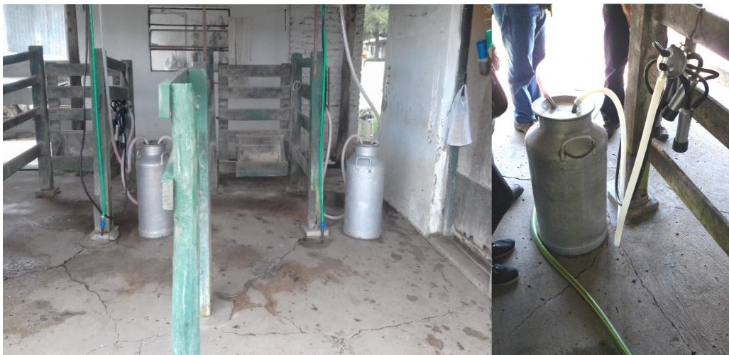
Figura 9. Vista de la sala de ordeño, con dos bretes a la par y piso de cemento. También se observa los tarros de leche y las bajadas de la máquina de ordeño.
