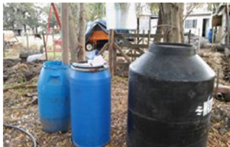
Figura 15. Tanques plásticos de diferentes volúmenes funcionando como cámara séptica
