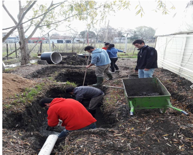
Figura 14. Construcción de pozos para colocación de cámaras sépticas y realización del humedal
