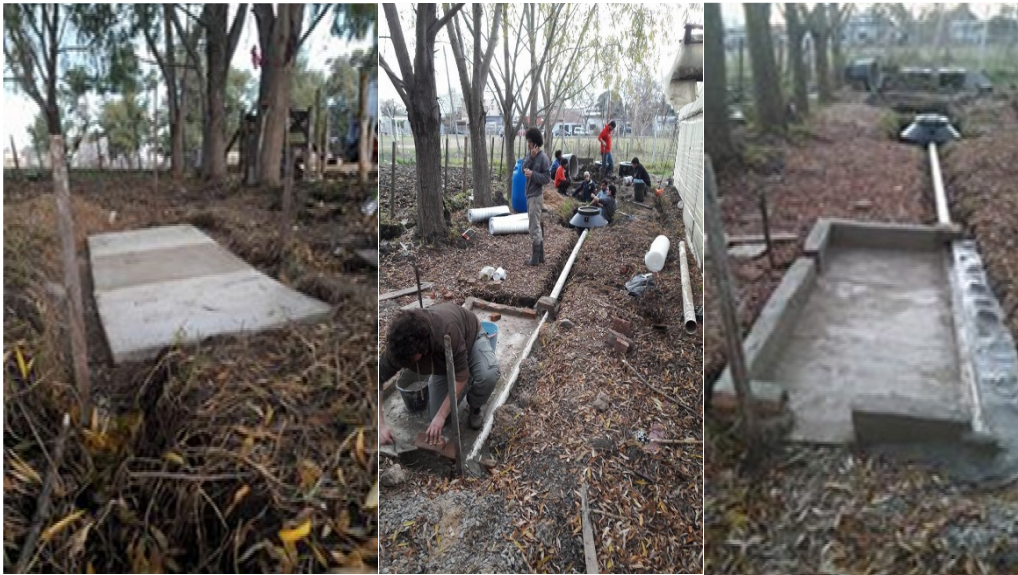
Figura 17. Construcción de Trampa estercolera
