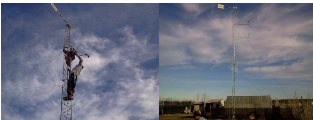
Figura 5: Instalación del boom con sensores de viento instalados e invernadero UNPA de fondo
