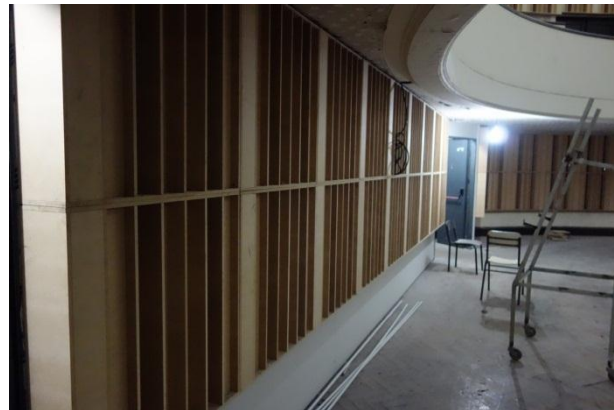
Figura 3. Módulo difusor propuesto y su colocación en el perímetro de la Sala (fotografía de la obra tomada en marzo de 2016).
