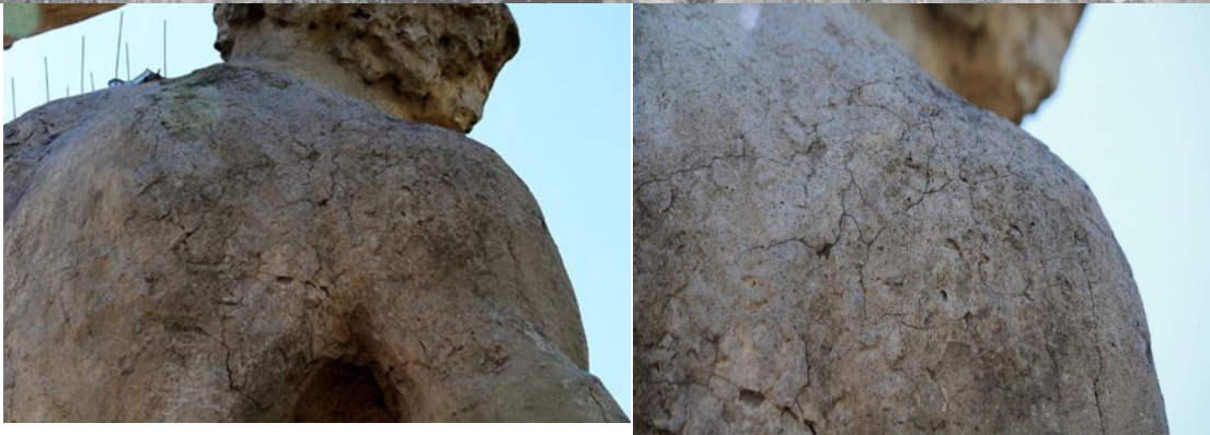
Figuras debajo. Hombro derecho. Fisuras múltiples combinadas
