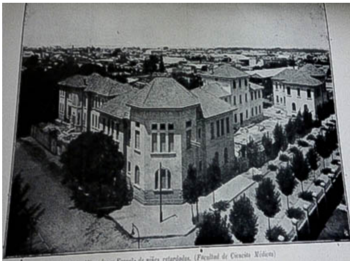
Vista del Avance de las obras del Hospital de Alienados. Pabellón destinado a la Escuela de Niños Retardados dependiente de la Cátedra de Neuro Psiquiatría Infantil. (Fuente: Memorias Araya, 1925) En cuanto al plano nacional, como mencionamos en el apartado anterior, el hermano
