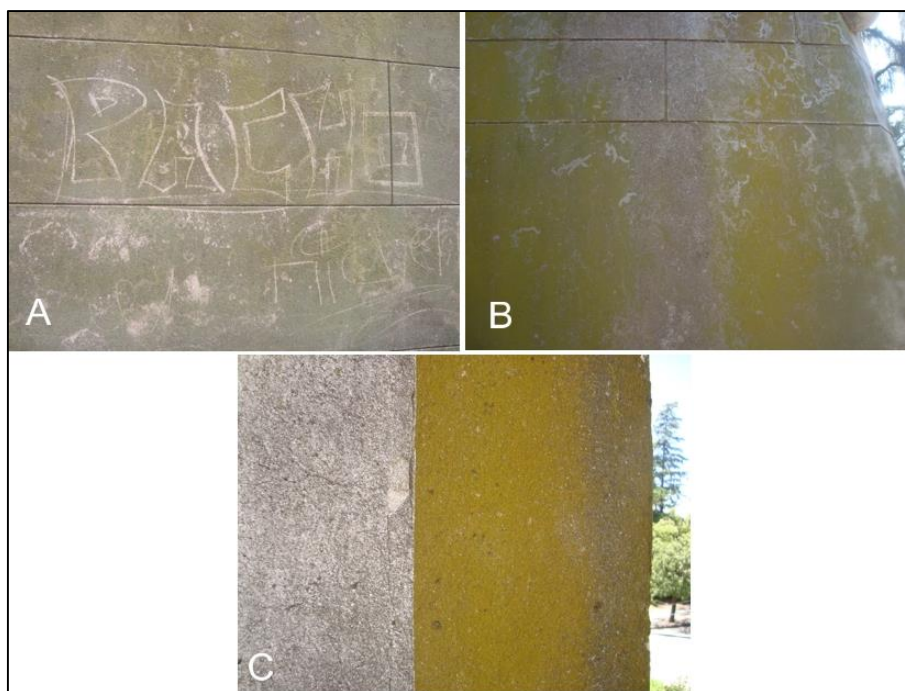
Figura IV.3. A= muro donde se uso los especios dejados por la limpieza de líquenes como grafitis; B= Marcas de gasterópodos que se alimentaron de los líquenes; C= sector a la izquierda hidrolavado, sector a la derecha no hidrolavado
