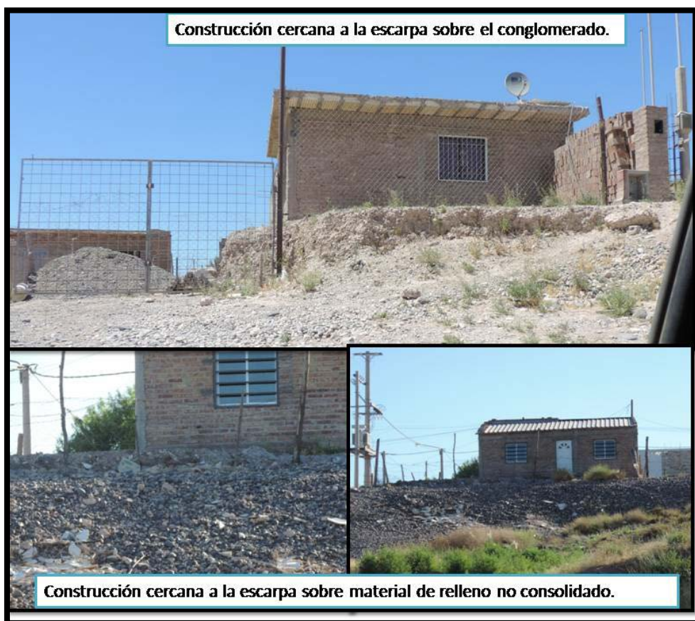
Figura 8.11: Vivienda en sectores de escarpa en el escalón de erosión.
