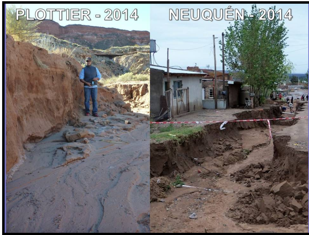
Figura 4.7: Proceso de carcavamiento acelerado en áreas de pendiente sin urbanización y con urbanización.
