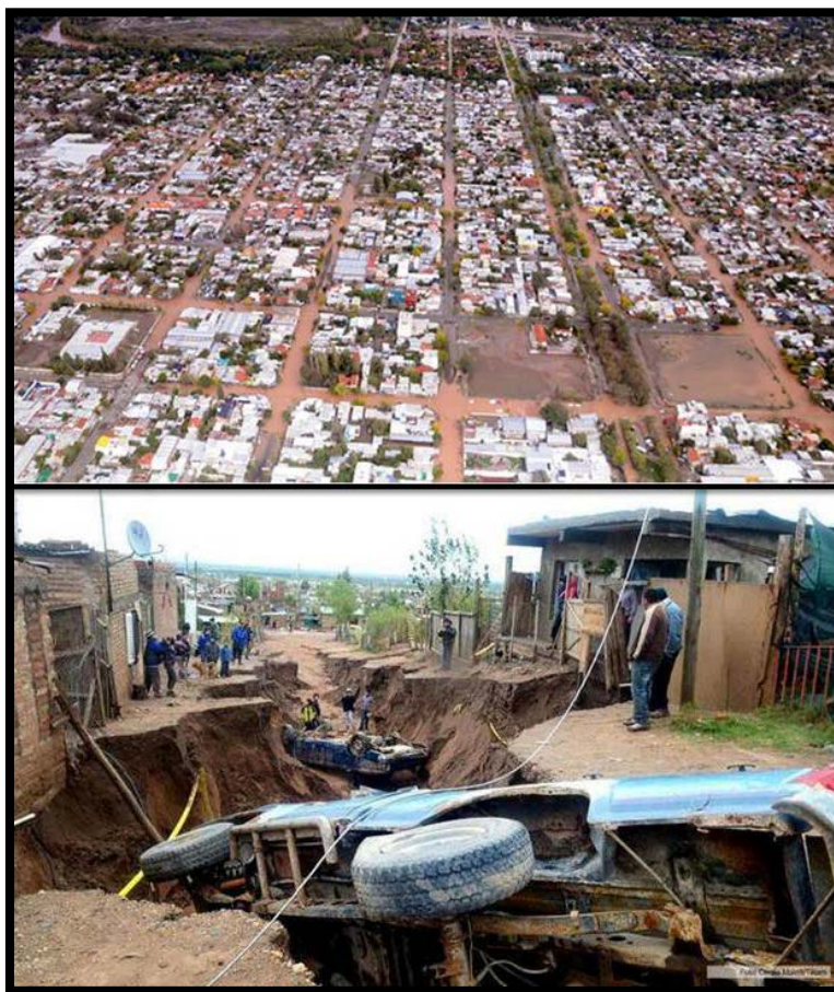
Figura 8.14: Daños generados por las lluvias de Abril de 2014, ciudad de Neuquén.
