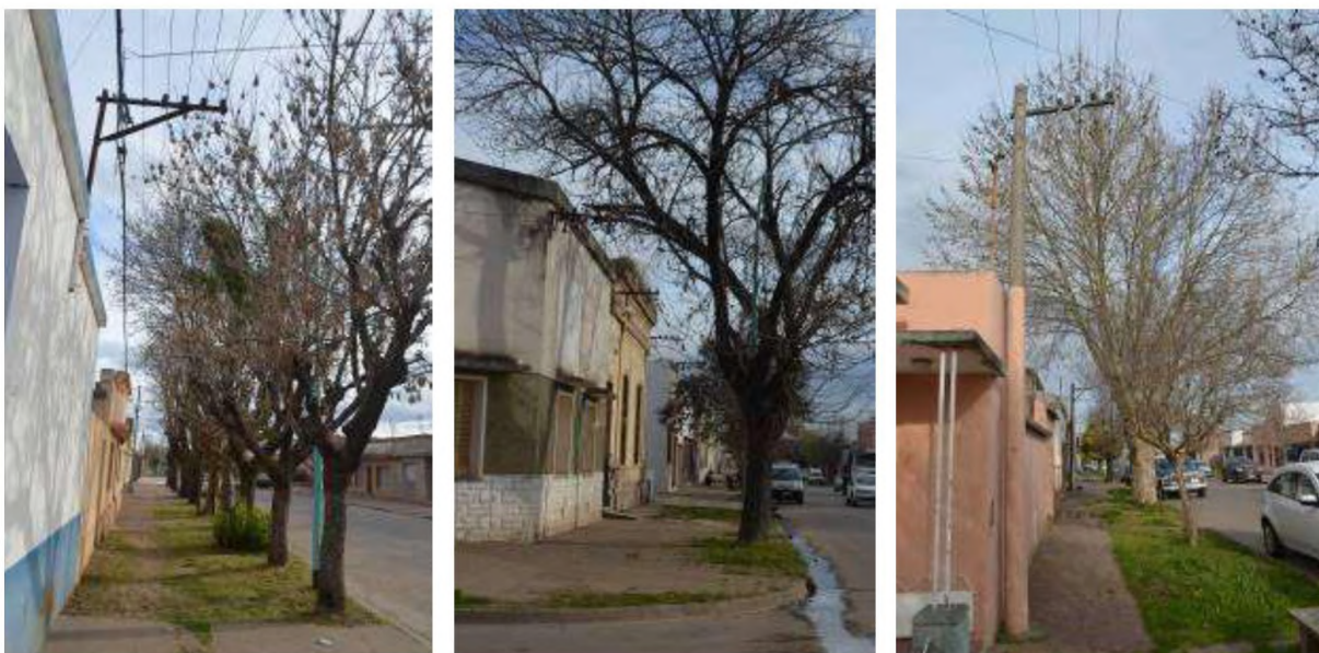
Figura 66. Barrio de Plaza Mitre, arbolado urbano y tendido eléctrico. (Fuente: Elaboración propia. 2016.)
