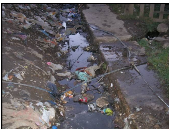
Figuras 5 y 6. Vista de las conexiones a la red de agua potable y descarga cloacal directa a la laguna.
