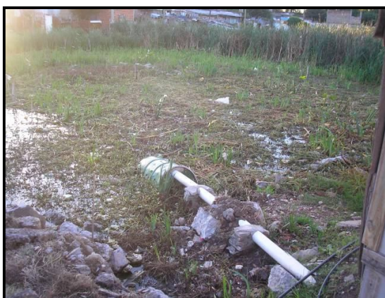
Figuras 5 y 6. Vista de las conexiones a la red de agua potable y descarga cloacal directa a la laguna.
