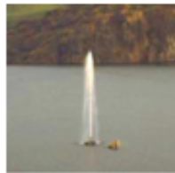
Figura 2: Adaptación realizada en el Lago Nyon, para lograr la liberación de CO 2 (g) producido en forma natural en el fondo del lago.
