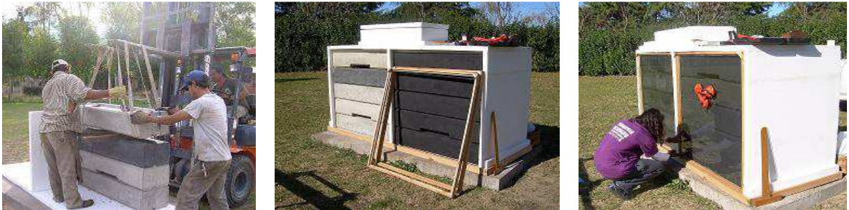
Figura 8: Montaje de los BOX con la instalación completa de los MAC (Sólido y mixto pigmentado y sin pigmentar) y sensores.
