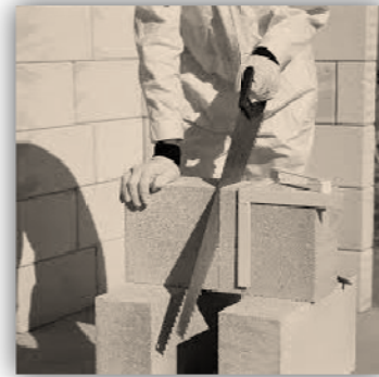
Imagen 2: Cortes de bloques Retak para mampostería.
