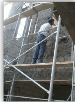
Imagen 2: Realización de revoques exteriores planta alta.
