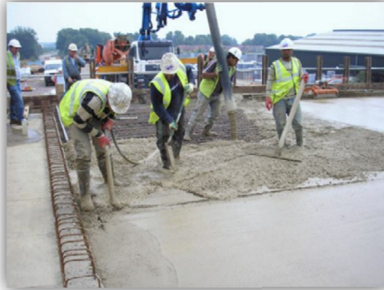
Imagen 16: Hormigonado sobre estructura de viguetas y bloques.
