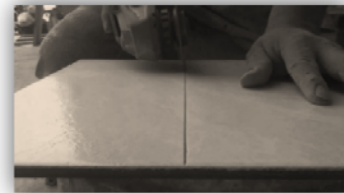
Imagen 3: Realización de cortes de cerámicos para revestimientos.
