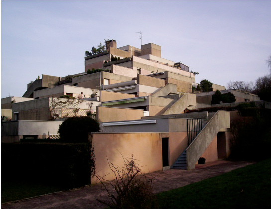
Figura 1: Conjunto de viviendas 'Les Pyramides' en Épernay, Francia. Andrault & Parat, 1963-1969.
