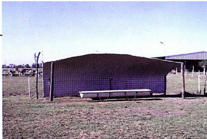
▲ Sistema colectivo: reparo con telas plásticas.
