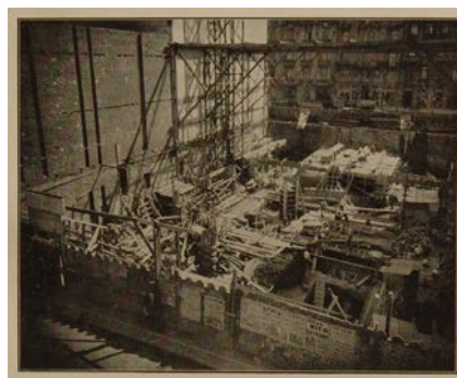
Comienzo de la obra. Pasaje Barolo Ca. 1920. Avenida de Mayo 1370, Buenos Aires. Ca. 1920. Mario Palanti. Quattro Anni..
