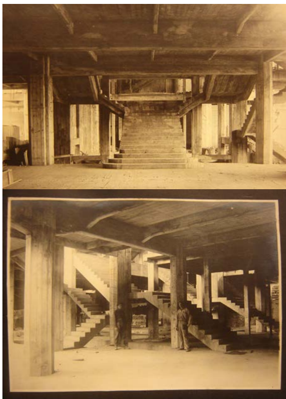
Mario Palanti. Palacio Salvo. Detalle de escalera principal en hormigón armado. Mario Palanti Papers, GRI. Los Angeles
