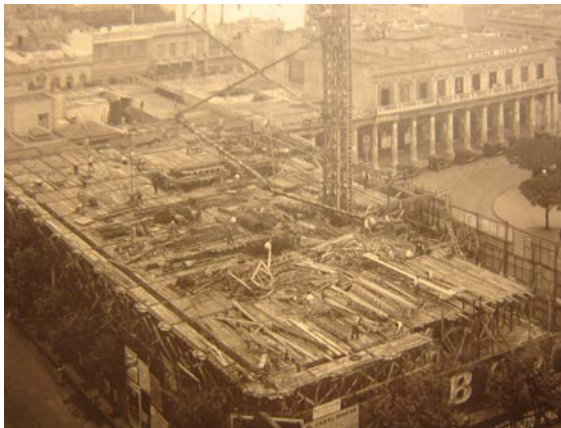
Secuencia de la construcción de la estructura de hormigón armado del Palacio Salvo (1923-1928), Montevideo. Arq. Mario Palanti, Ing. Gori Salvo, Empresa Constructora Dickerhoff & Widmann. Mario Palanti Papers, GRI. Los Angeles.
