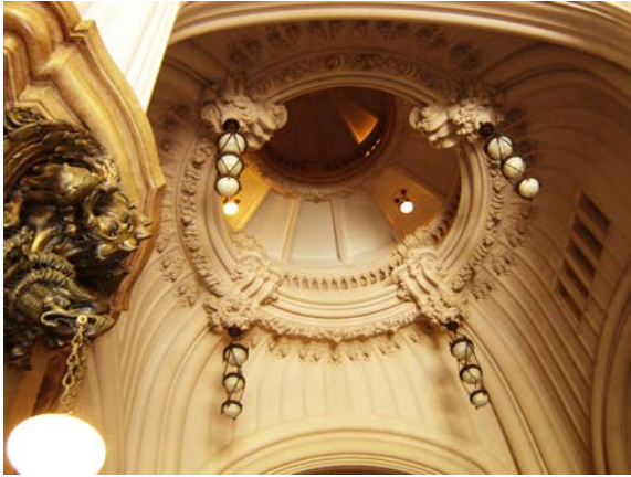
Detalles ornamentales que acompañan la secuencia de vacíos y cúpula interior sobre el punto central del pasaje. Pasaje Barolo. Avenida de Mayo 1370, Buenos Aires. (1919-22). Mario Palanti. Foto Virginia Bonicatto
