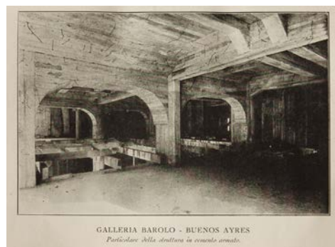
Detalle de la construcción de la estructura porticada del pasaje. Pasaje Barolo (1919-22). Avenida de Mayo 1370, Buenos Aires. Ca. 1919. Mario Palanti. Quattro Annidi lavoro
