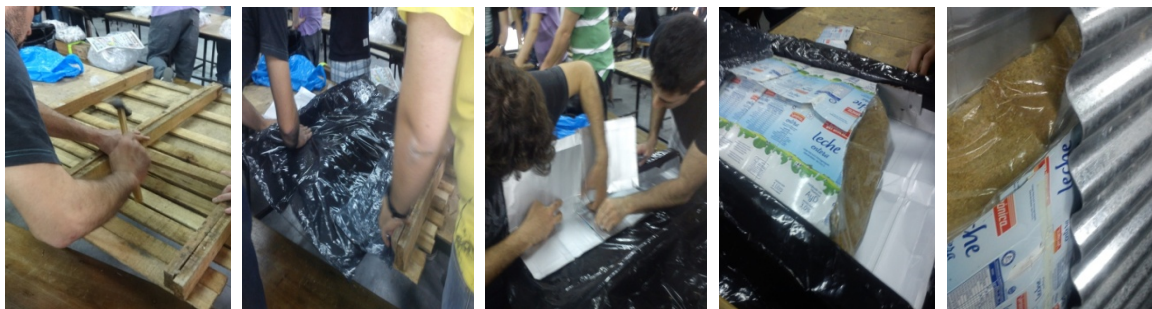
Armado de base con madera recuperada
