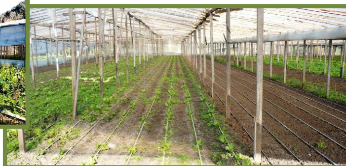
Foto 1b. Unidad de gestión bajo cubierta.
