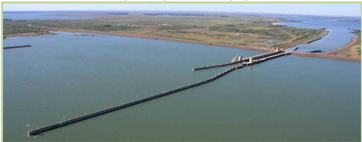
Foto N° 59: Vista aérea de la Esclusa de Navegación desde aguas arriba del embalse principal
