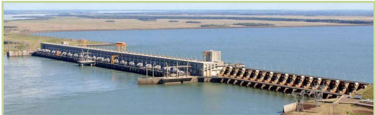
Foto N° 54: Central Hidroeléctrica y Vertedero Principal
