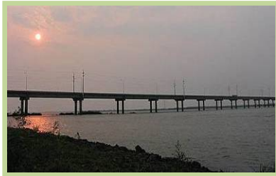
Foto N° 52: Puente hacia Ayolas (PY)
