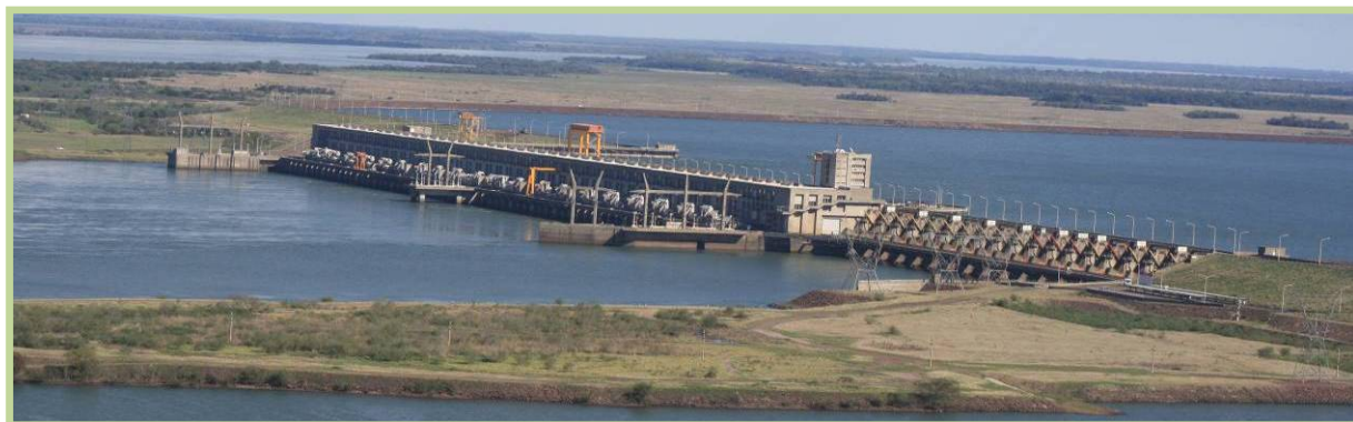
Foto N° 60: Líneas de Transmisión Eléctrica que salen desde la Central hacia la Argentina y Paraguay
