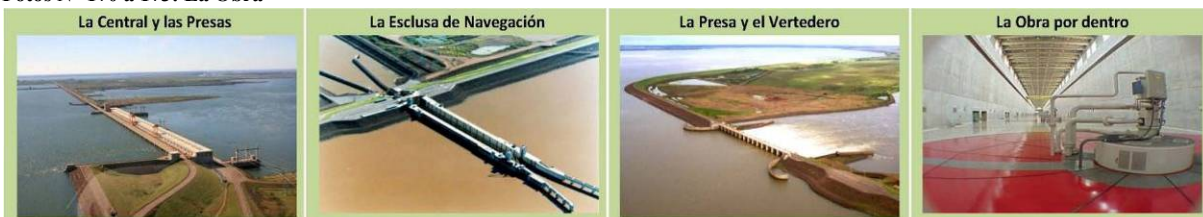
Fotos N° 170 a 173: La Obra
