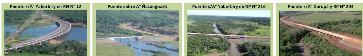
Fotos N° 132 a 135: Obras Viales en la Provincia de Misiones
