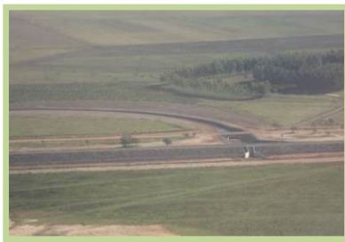
Foto N° 53: Toma de Riego MD
