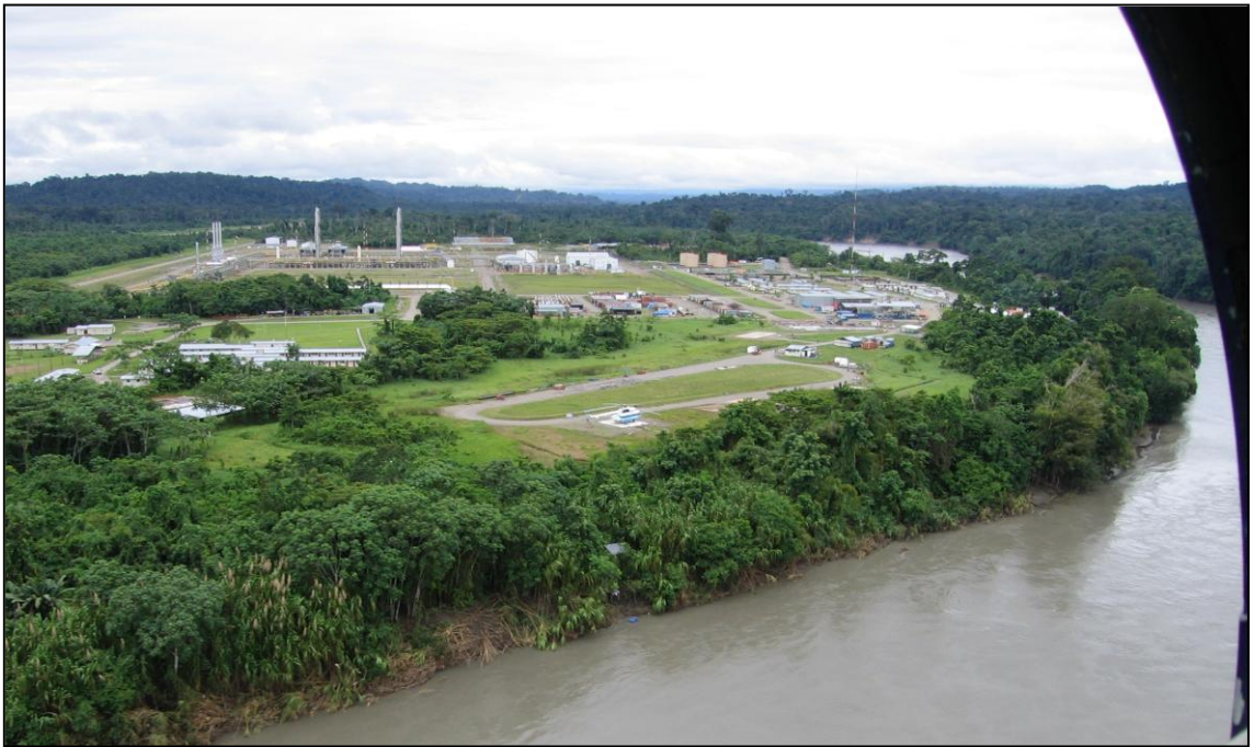
Figura 2.3. Vista aérea de la Planta de Gas Las Malvinas, ubicada sobre la orilla oriental del Río Urubamba en la región de Camisea, representa el límite entre los componentes Upstream y Downstream.
