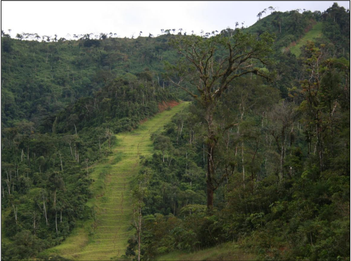
Figura 2.4. Derecho de Vía, bajo el cual se ubican los ductos que forman parte del componente Downstream y que van desde la Planta de Gas Las Malvinas hasta la costa del Océano Pacífico, a la altura de Paracas.
