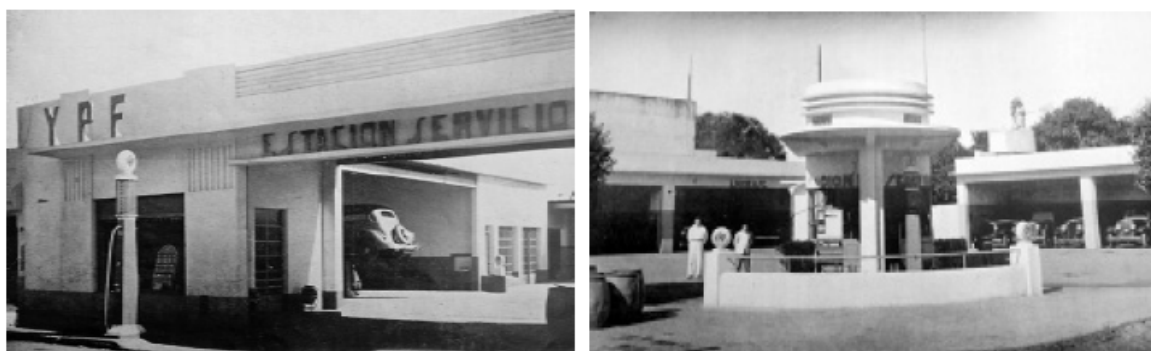
Fig 2. infraestrutura de estações de serviço e venda de combustível.
