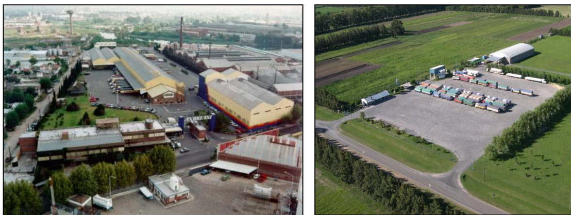
Figura 22: CENTROS DE TRANSFERENCIAS DE CARGA
