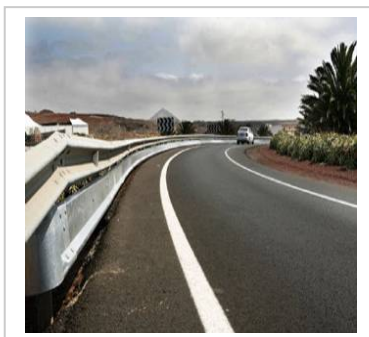
Defensas Metálicas Flexibles entre la ruta y la colectora, para más seguridad de quienes circulan por ambas vías
