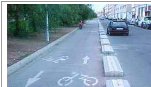
Carril de doble sentido con delimitación de elementos premoldeados hacia la calzada y demarcación horizontal. El carril es “fuelle” entre los espacios definidos para las circulaciones peatonal y vehicular respectivamente
