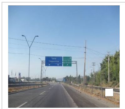
Barrera de contención metálica
