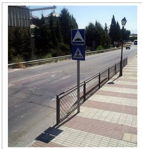
Las vallas peatonales son un recurso, que protege al peatón impidiéndole cruces o tránsitos peligrosos
