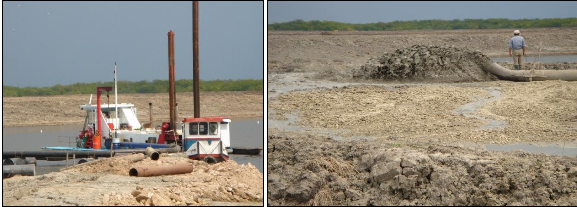
Figura 3: Obras realizadas para la conformación de las UCAs En página 25 remoción de suelos para la conformación de lagunas. Emprendimiento “El Cantón”. En esta página, draga realizando tareas de refulado hidráulico. Emprendimiento San Sebastián, Pilar. Fuente: Pintos, 2010
