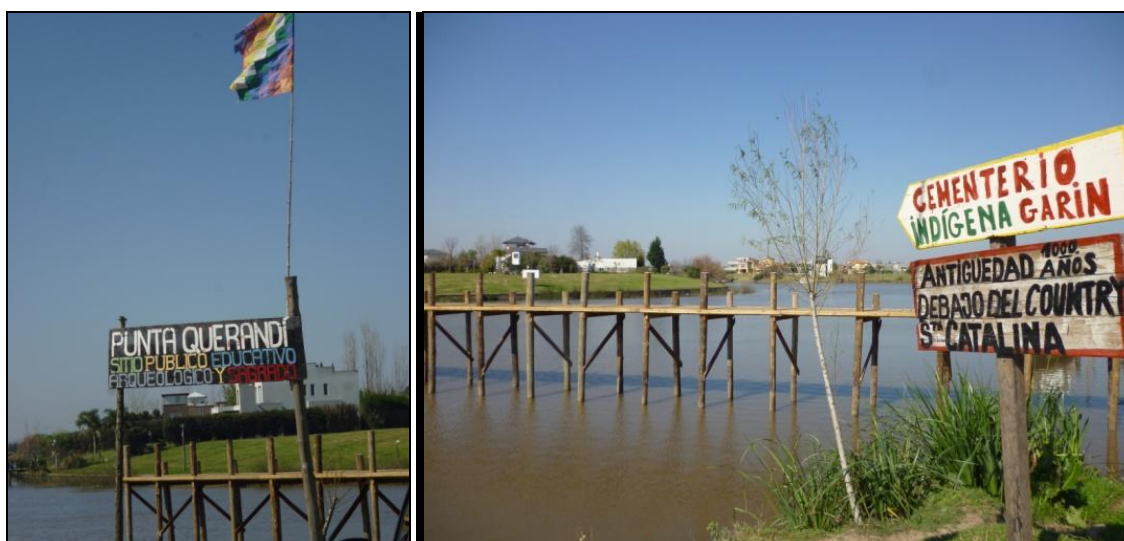
Figura 52: Barrera construida por EIDICO Fuente: Vallejo, agosto de 2014
