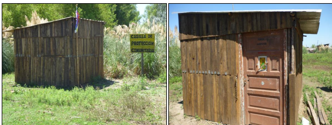
Figura 57: Casilla de protección comunitaria Fuente: Vallejo, febrero 2017
