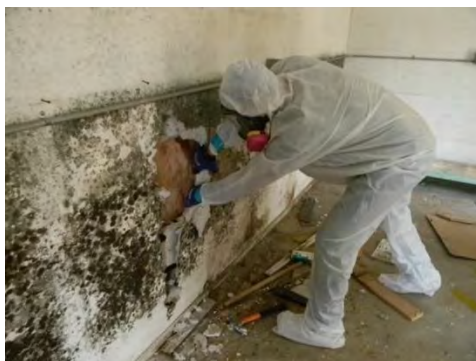
Figura 38: Remoción de moho negro tóxico.
