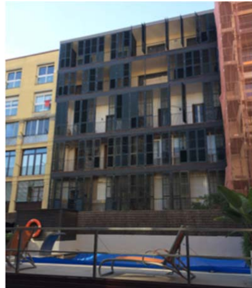
Fig. 9: Rambla Catalunya 82, fachada posterior renovada
