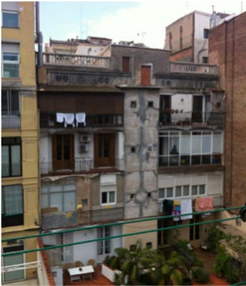
Fig. 8: Rambla Catalunya 82, fachada posterior sin intervenir
