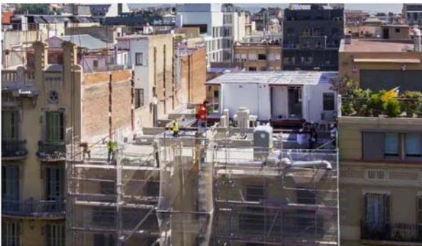
Fig. 6: Rambla Catalunya 82, montaje a medio ejecutar
