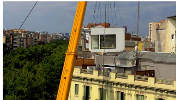
Fig 7: Gran Vía 504, montaje de módulos
