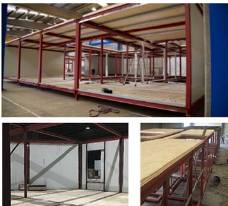
Fig. 4: Arquitectura industrializada, estructura y cerramientos
