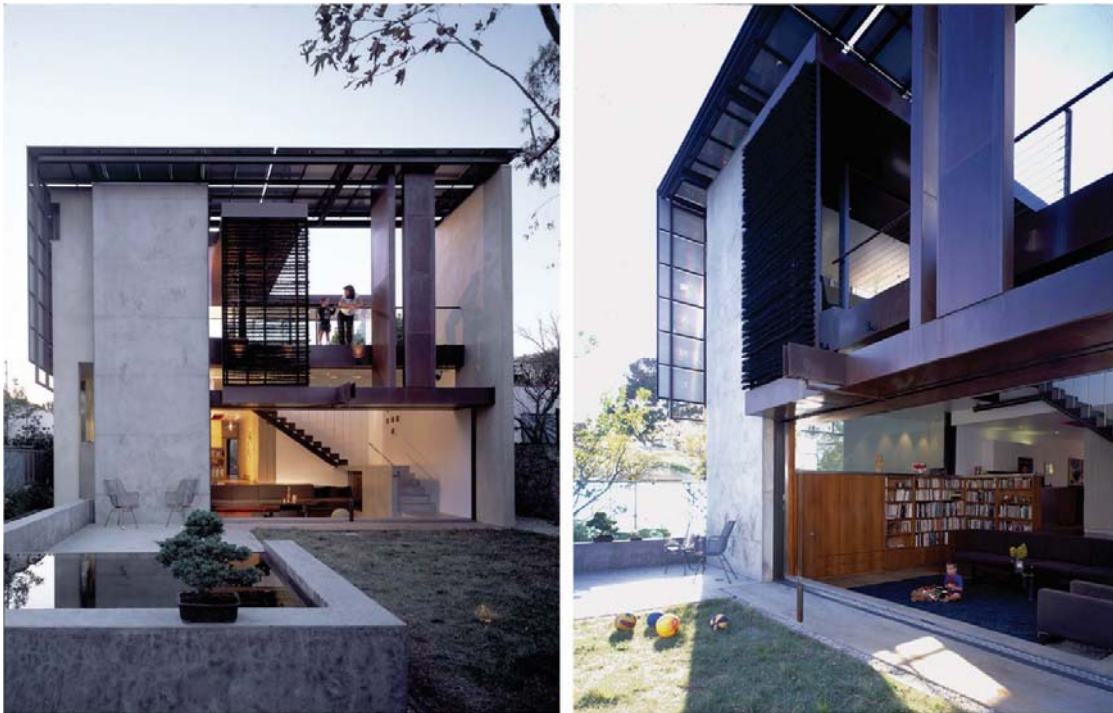
Fig. 4. Imagen exterior de la Solar Umbrella House en la que se observa el sobretecho fotovoltaico que la caracteriza. El gran paraguas solar colabora con la concreción de una gran fluidez entre espacio interior y exterior. Fuente: http://brooksscarpa.com/solar-umbrella-house
