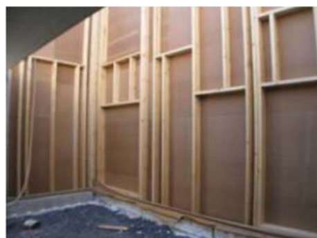
Fig.5 - Rigidización con revestimiento colaborante Fuente: Internet.
