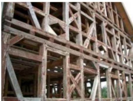
Fig. 4 - Rigidización con triangulación mediante diagonales. Fuente: Internet.
