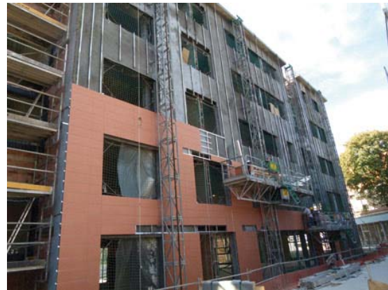
Fig. 3 Fachada ventilada en proceso de ejecución. Fuente: Internet
