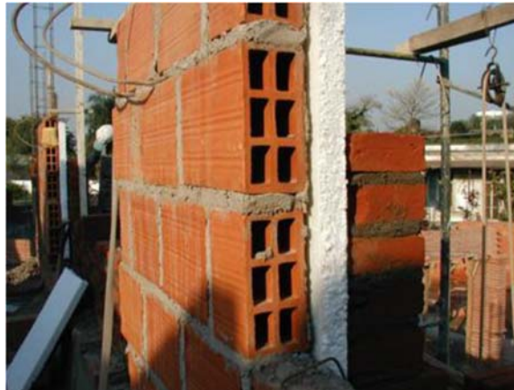
Fig. 1. Detalle de sector de pared doble, de ladrillo visto. Fuente: Fotografía de los autores.
