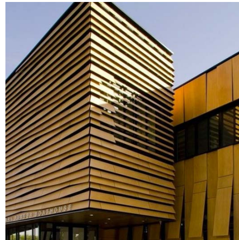
Fig. 7 Fachada ventilada de madera con lamas horizontales. Fuente: Internet
