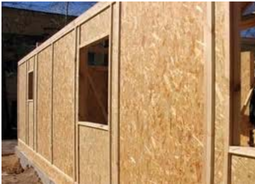
Fig. 10 – Paredes exteriores con tableros de OSB Fuente: Internet
