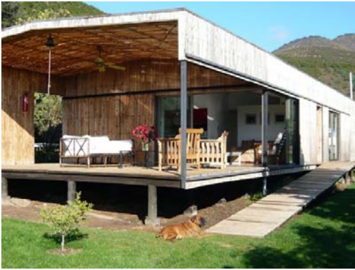
Fig. 8 - Vivienda realizada con madera de pallets Fuente: Internet
