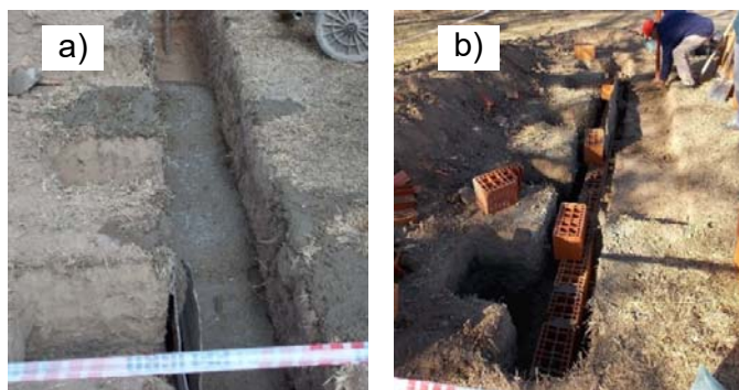
Fig. 2- Fotografías del modelo físico realizado. a) Ejecución del cemento “común”. b) Colocación de los mampuestos
