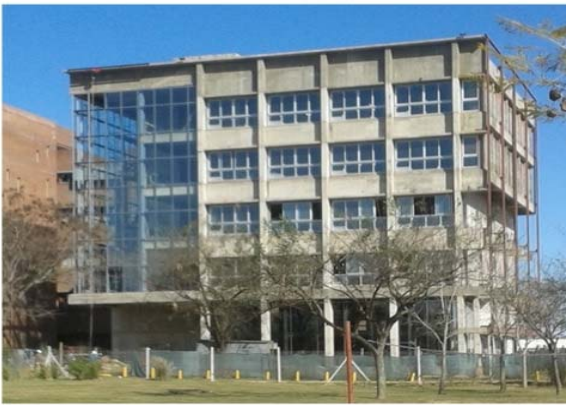
Fig.2 Fotografía edificio el “Cubo”
