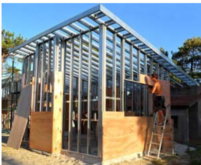
Fig. N° 7 . Placas estructurales madera (multilaminadas). Fuente ( internet)
