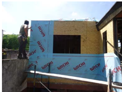
Fig. N° 10. Colocacion de barrera contra viento e hidrofuga, sobre placas de madera OSB. Fuente : Internet
