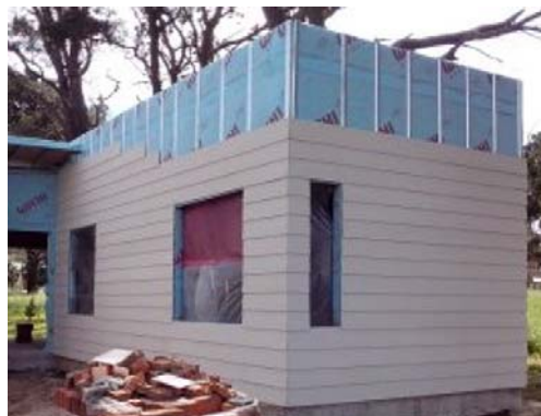
Fig. Nº 13. Placas tipo siding de fibrocemento, con textura simil madera con espesores de 6, 8, 10 y 15 mm y de largos de 1.80m a 3,60 m. Se atornillan sobre perfiles de chapa galvanizada fijados a la pared. Fuente : Internet
