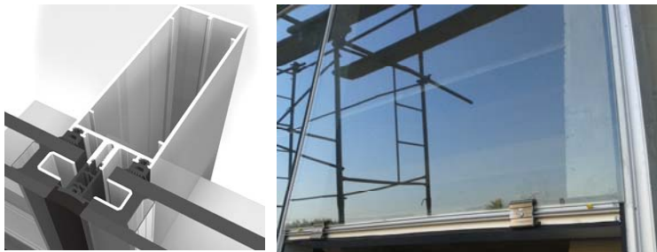
Fig. N° 6 Panel de vidrio, fijado atornillado, sobre burletes y sellado de juntas.
