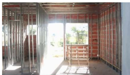
DESARROLLO DE CONSTRUCCIÓN DE LAS VIVIENDAS CON SISTEMA MIXTO
